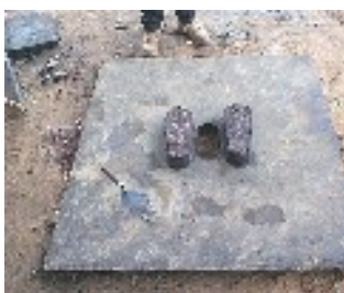
Dalle de latrines
